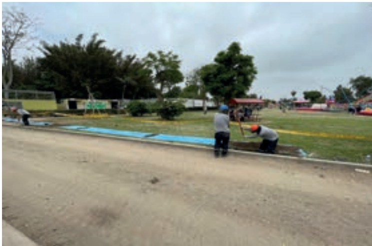
Figura 8: Trabajos de zanqueo manual para instalación de sistema de riego tecnificado
