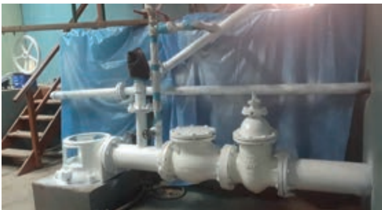
Figura 2: Pintado de árbol de descarga
