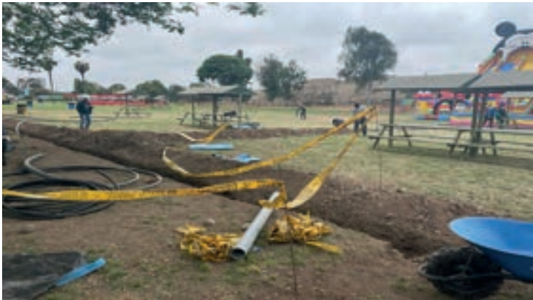
Figura 7: Trabajos de zanqueo manual para instalación de sistema de riego tecnificado
