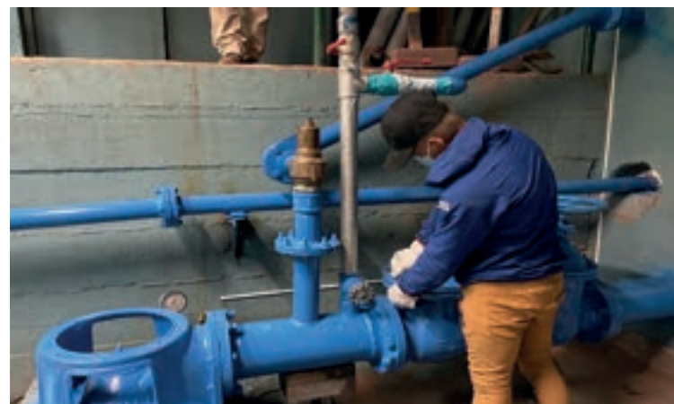
Figura 4: Mantenimiento correctivo a árbol de descarga
