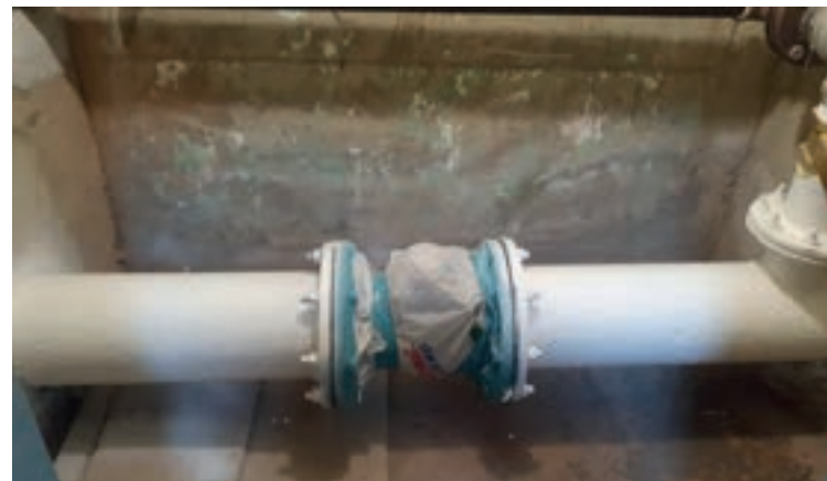
Figura 3: Pintado de árbol de descarga
