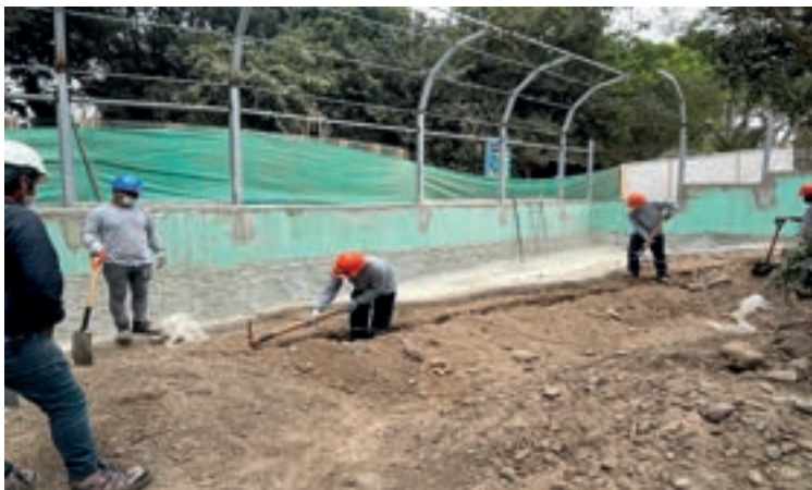
Figura 13: Trabajos de zanqueo manual para instalación de sistema de riego tecnificado
