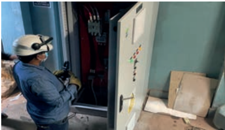
Figura 6: Mantenimiento preventivo a tablero eléctrico
