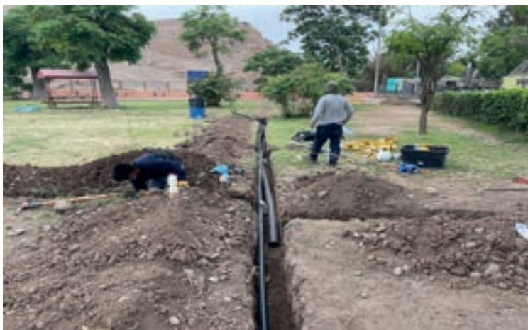
Figura 9: Instalación de tuberías para instalación de riego tecnificado
