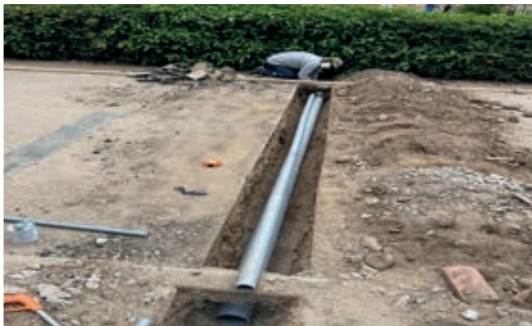
Figura 14: Instalación de tuberías para riego tecnificado
