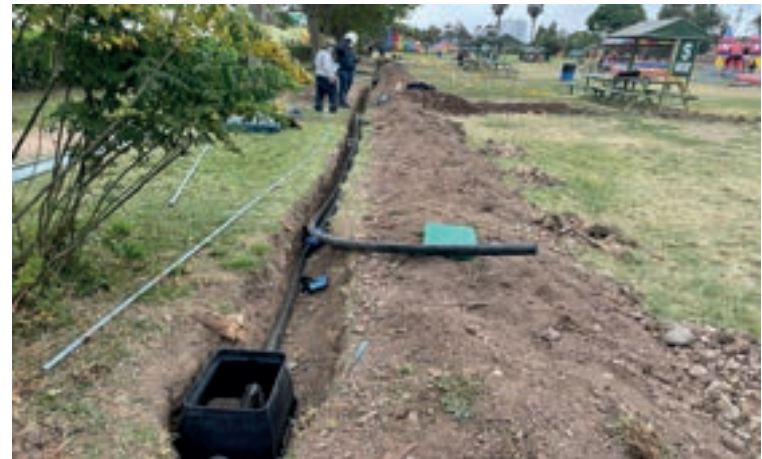
Figura 11: Instalación de tuberías para instalación de riego tecnificado
