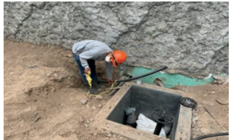
Figura 12: Trabajos de zanqueo manual para instalación de sistema de riego tecnificado
